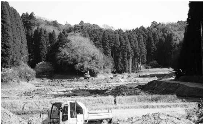
▲坂本利根里地区の土地改良工事
