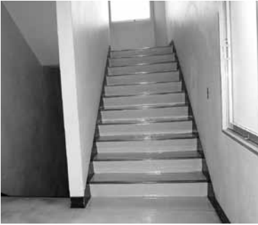
▲庁舎東側階段に手すりの設置は
