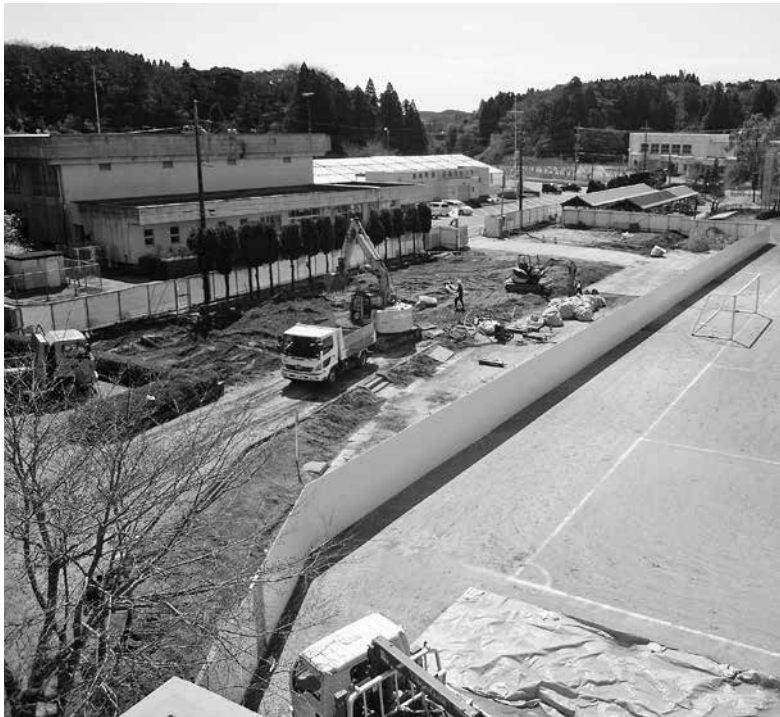
工事が始まった統合小学校
