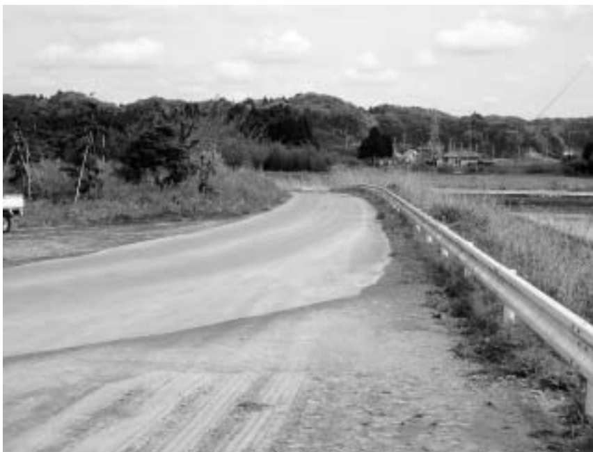
水沼と岩撫を結ぶ連絡道
