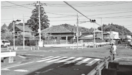
改良が進む給田交差点
